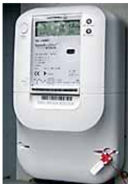
Box mit GPRS-Sender und PLC System
